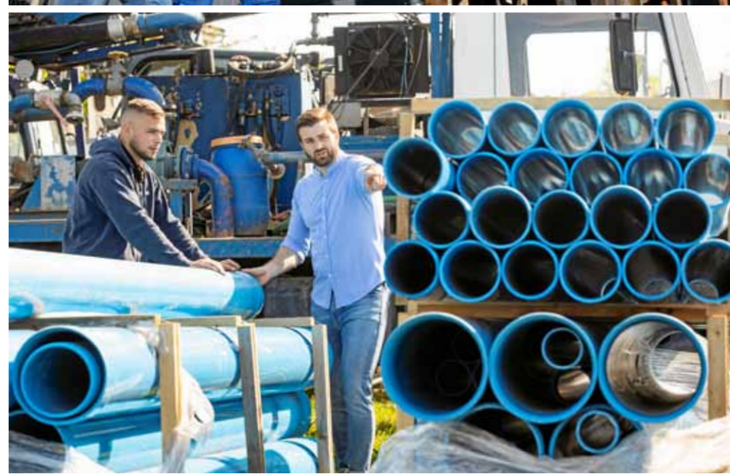
Für Wasser- und Erdwärmeh Bohrungen bedarf es imposanter Technik. Projektleiter und Ingenieur Malte Mäding (r.) und Azubi Fabian Gödecke auf der Baustelle. Fotos: t&w
